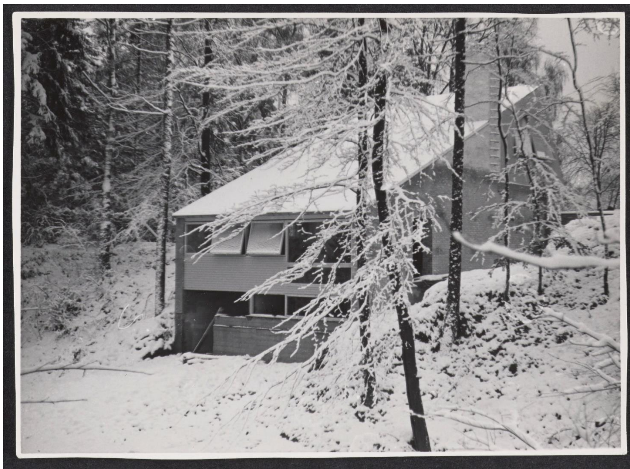
Geelsvej 10 under opførsel i vinteren 1953/54. Bemærk den brædeforskallede betonmur i kælderen. Foto: Strüwing. Kilde: Det Kongelige Biblioteks digitale samlinger.
