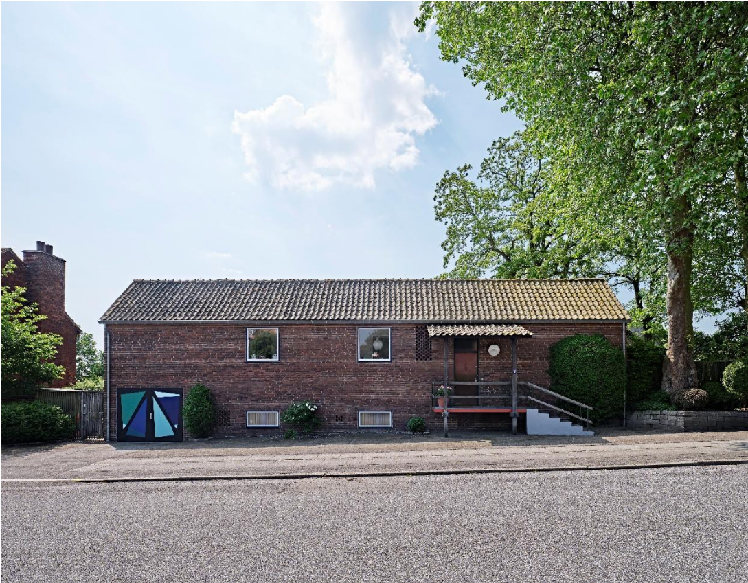
Husets nordvendte facade med garageport. Foto: Anders Sune Berg, 2021.
