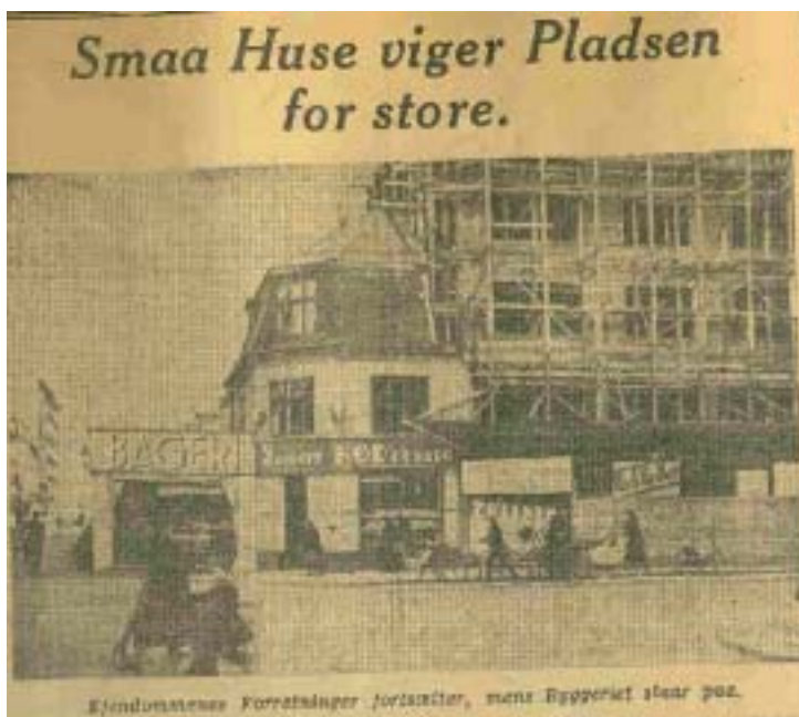
Byggeriet er ved at tage form
