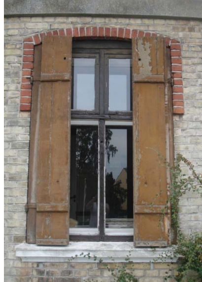
Vinduerne har skodder, der kan lukkes halvt og helt. Når de er helt lukkede, kan skodderne boltes fast gennem lodposten.
