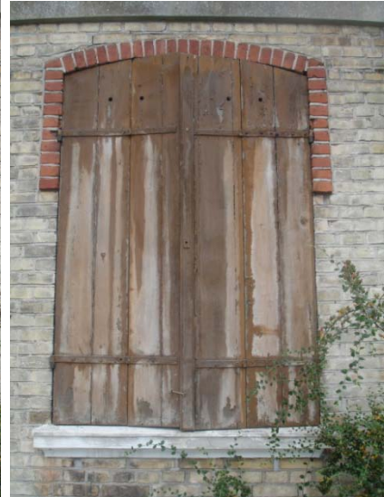
Vinduerne har skodder, der kan lukkes halvt og helt. Når de er helt lukkede, kan skodderne boltes fast gennem lodposten.
