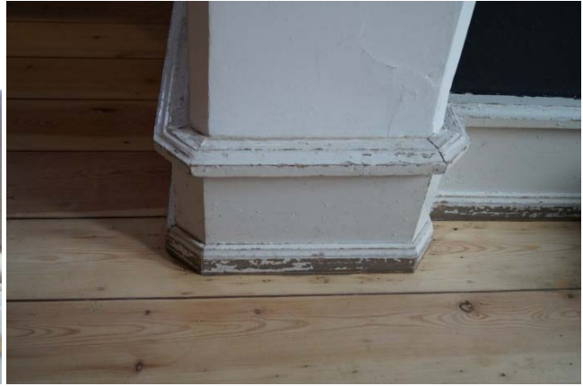
Øverste hulkehl har været belagt med bladguld
