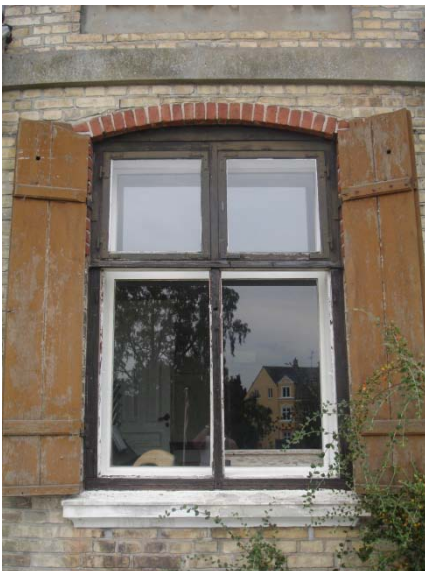
Vinduerne har skodder, der kan lukkes halvt og helt. Når de er helt lukkede, kan skodderne boltes fast gennem lodposten.
