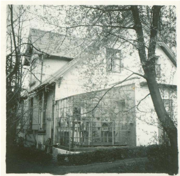
Orangeriet og tilbygningen på et foto fra mellem 1929-67
