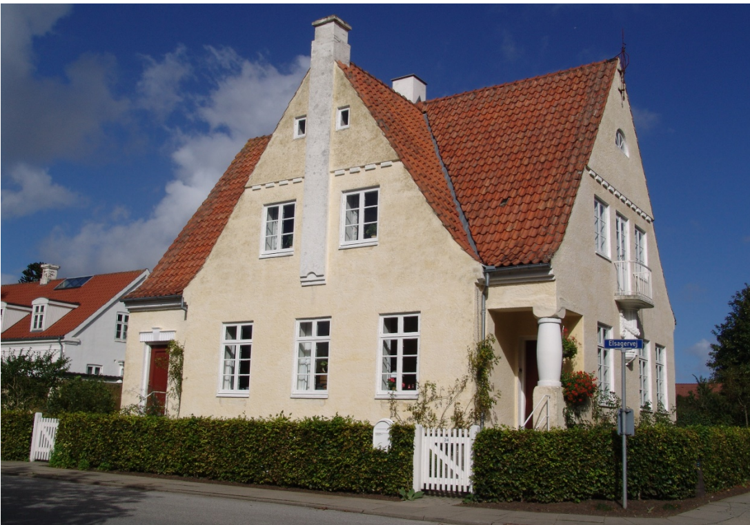
Fotografi fra 2015, bygningens sydvestlige hjørne efter knap 100 år
