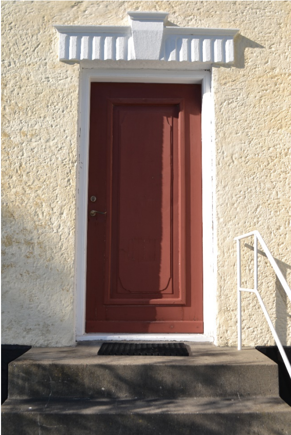
Sidenindgang med fordakning støbt i cement
