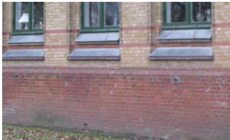
Sokkel afsluttes af rulleskifte. Bemærk også de to rækker sålbænke.
