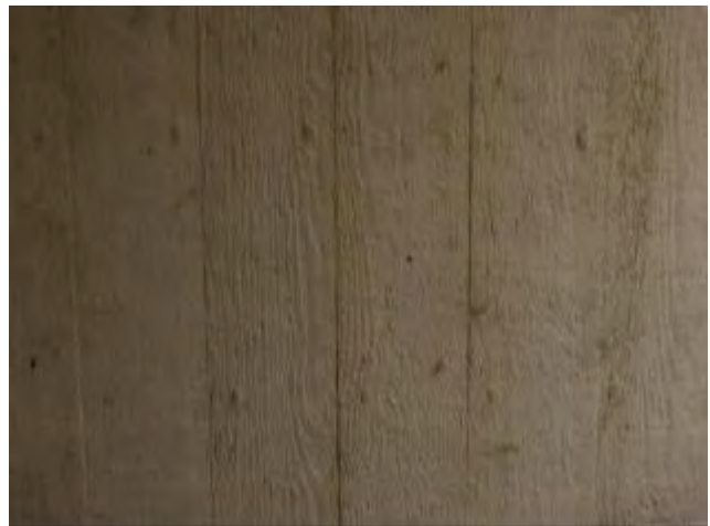
Forskallingens fine struktur ses i den in-situ-støbte beton.
