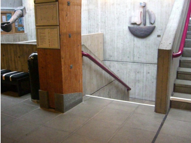
Trappe til bygningens underste etage, fra ankomstarealet.
