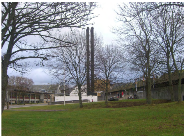
Varmecentralen nord for hallerne.
