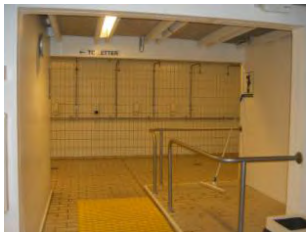
Overgang fra omklædnings- til badeafsnit.
