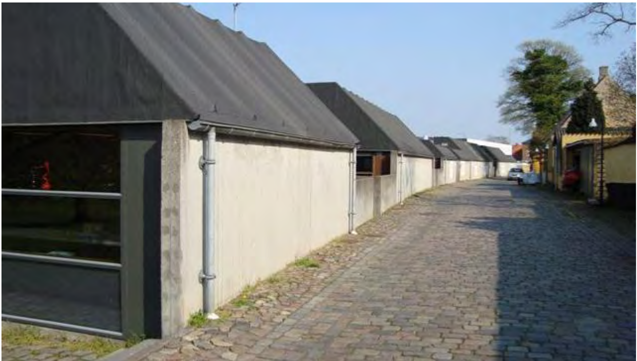
Kalundborghallernes sydfacade, der indgår i Højbyens gadestruktur.
