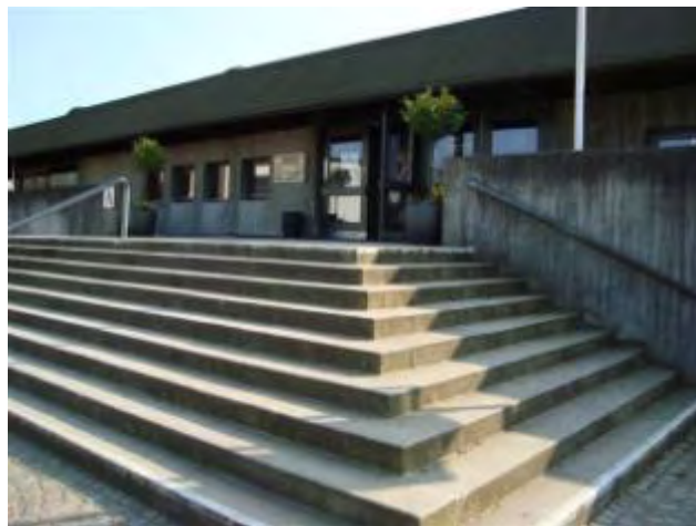
Trappen, der fører på til hovedindgangen.
