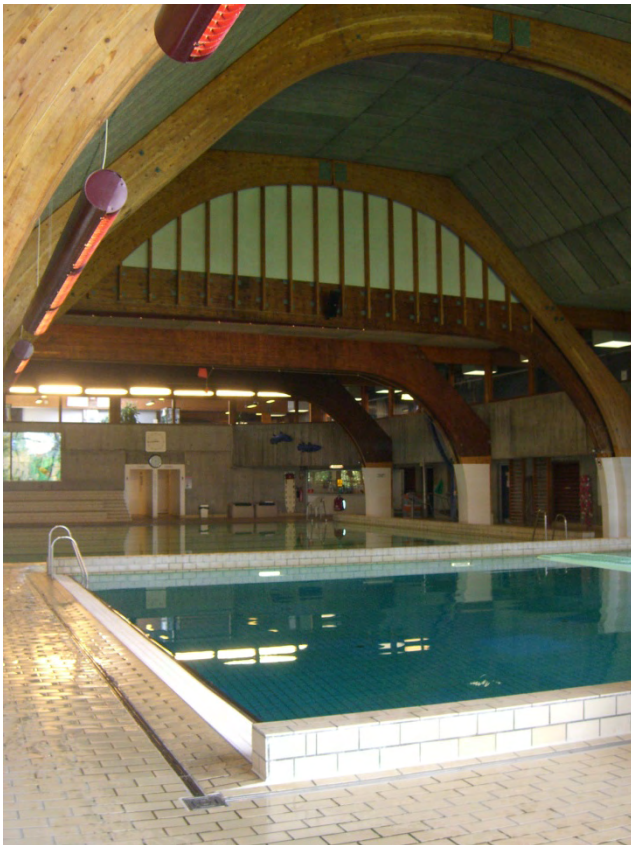
Svømmehallens loft er højest over udspringsbassinet.
