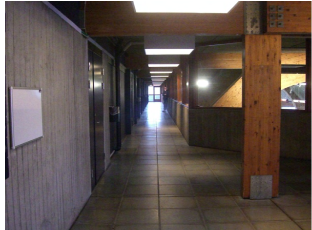
Kontorgang over svømmehallen.
