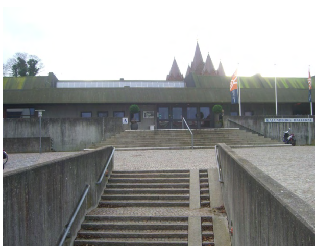
Nordfacaden fra J.H-P. vej.
