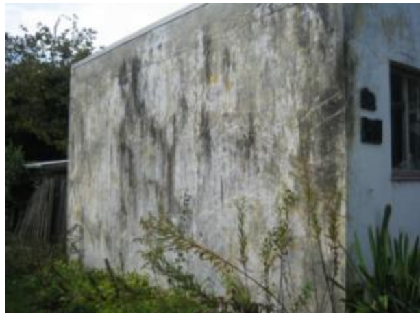
Mur på sydboksen
