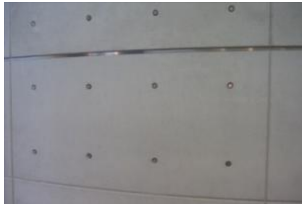
Detalje med opdeling af betondelene.
