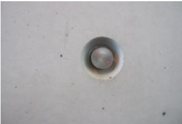
Detalje af den støbte beton.
