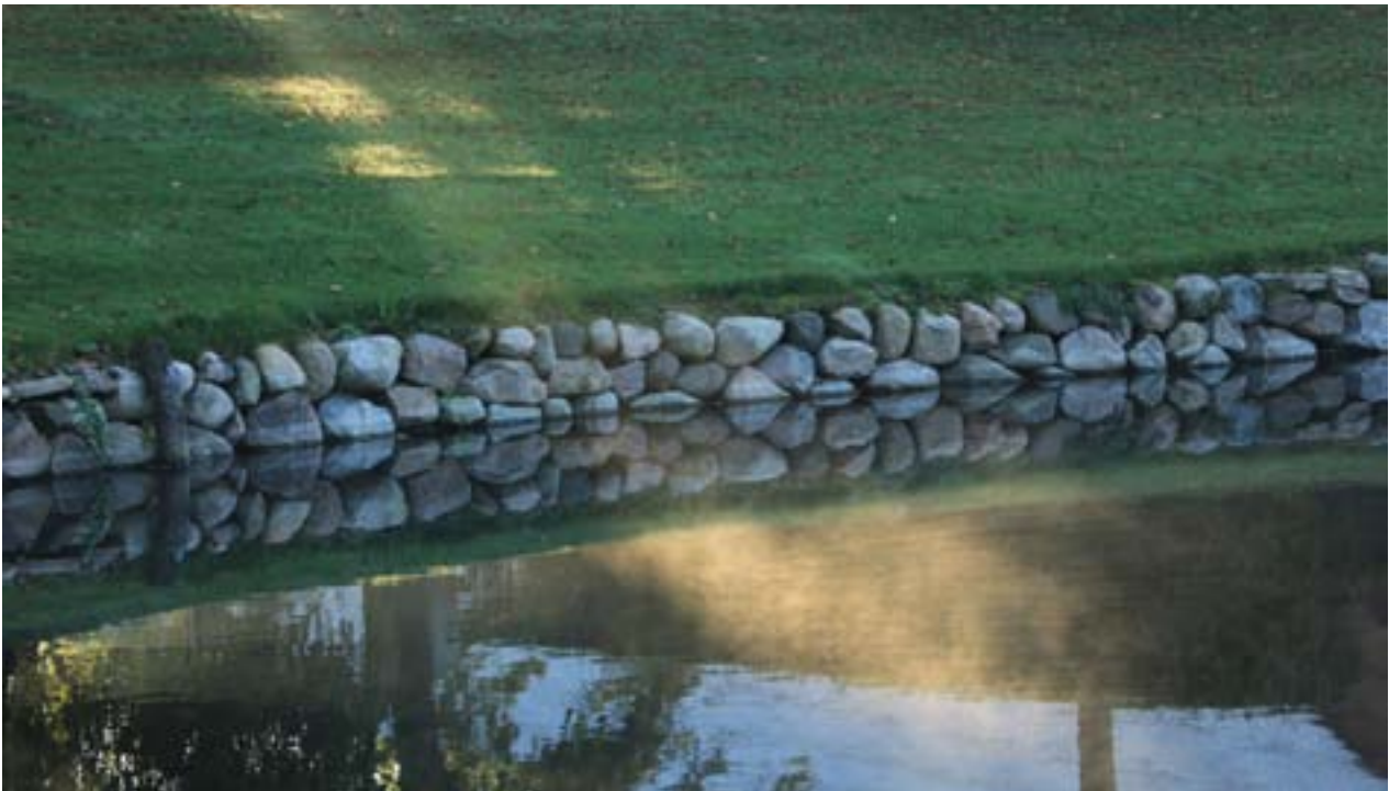
Et præcist møde mellem land og vand. Korrekt udført kan en kampestensmur holde i flere hundrede år. Holstenshuus.
