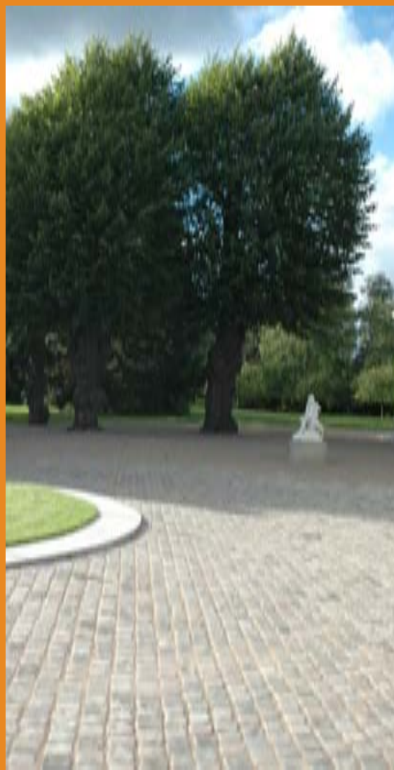
Brostensbelægning sat i lige skifter og brudt af en bred granitkantsten.
