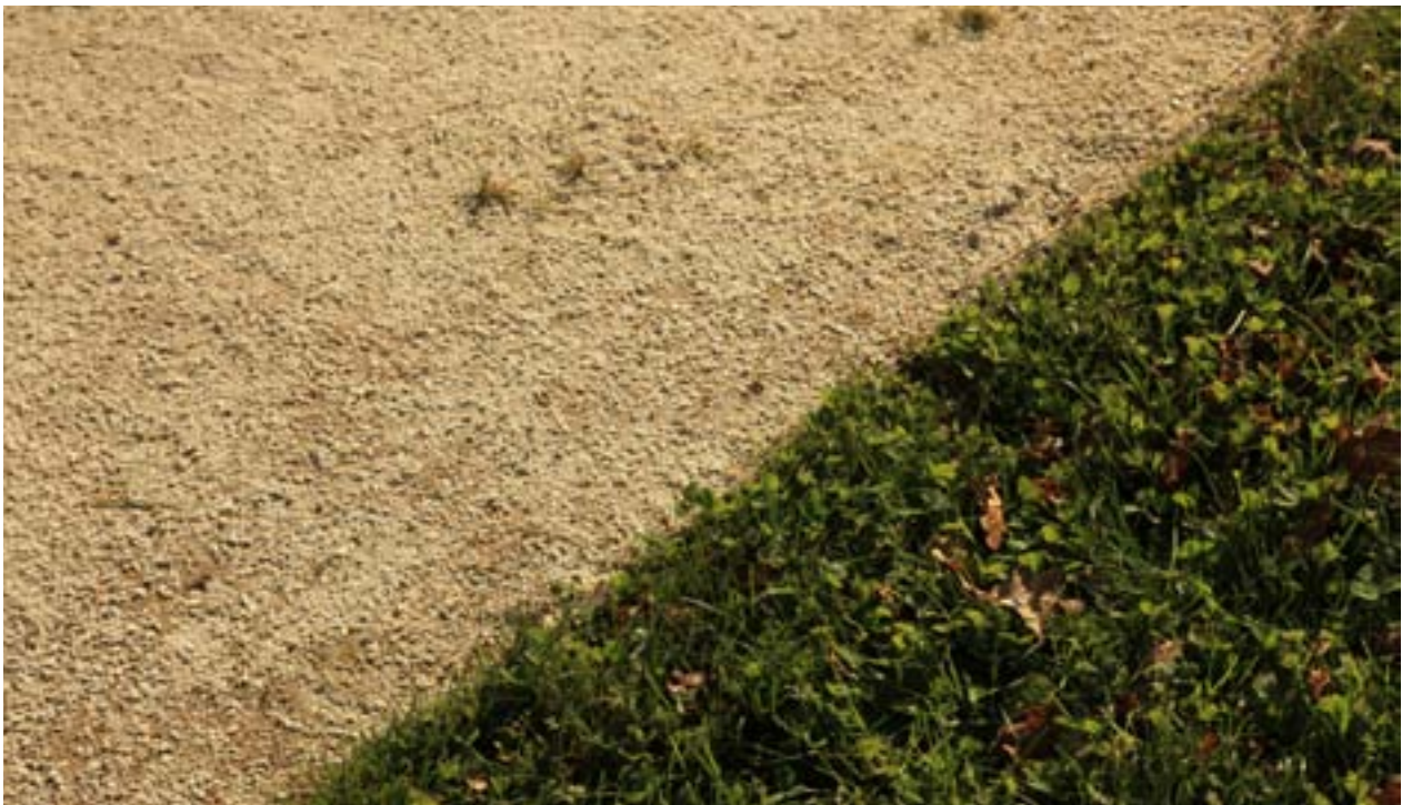
Grusopbygningen mod græsfladen styrkes af en jernkant, der hindrer græsset i at vandre ind i stien. Engelsholm.
