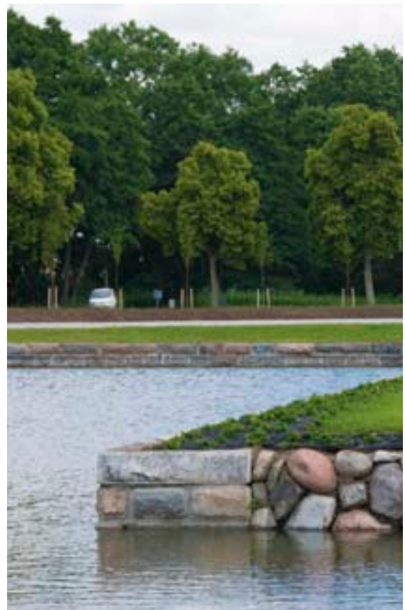
Hele voldgraven har været tømt, bunden er blevet rensset og kanterne er enten renoverede eller nykonstruerede.
