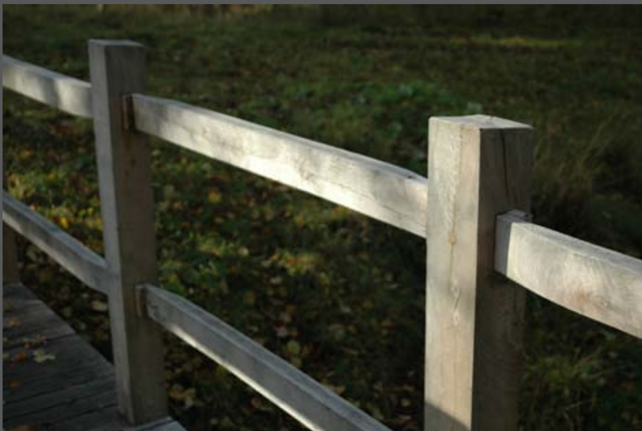
Gangbro med rækværk udført i egetræ uden brug af skruer. Løvenborg.
