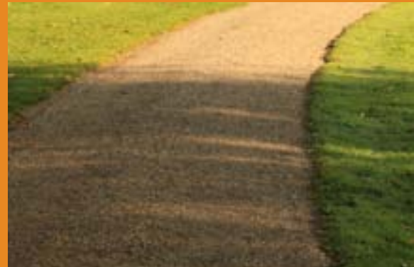
Slotsgrusbelægning med 25 ‰ afvandingsfald til siderne.
