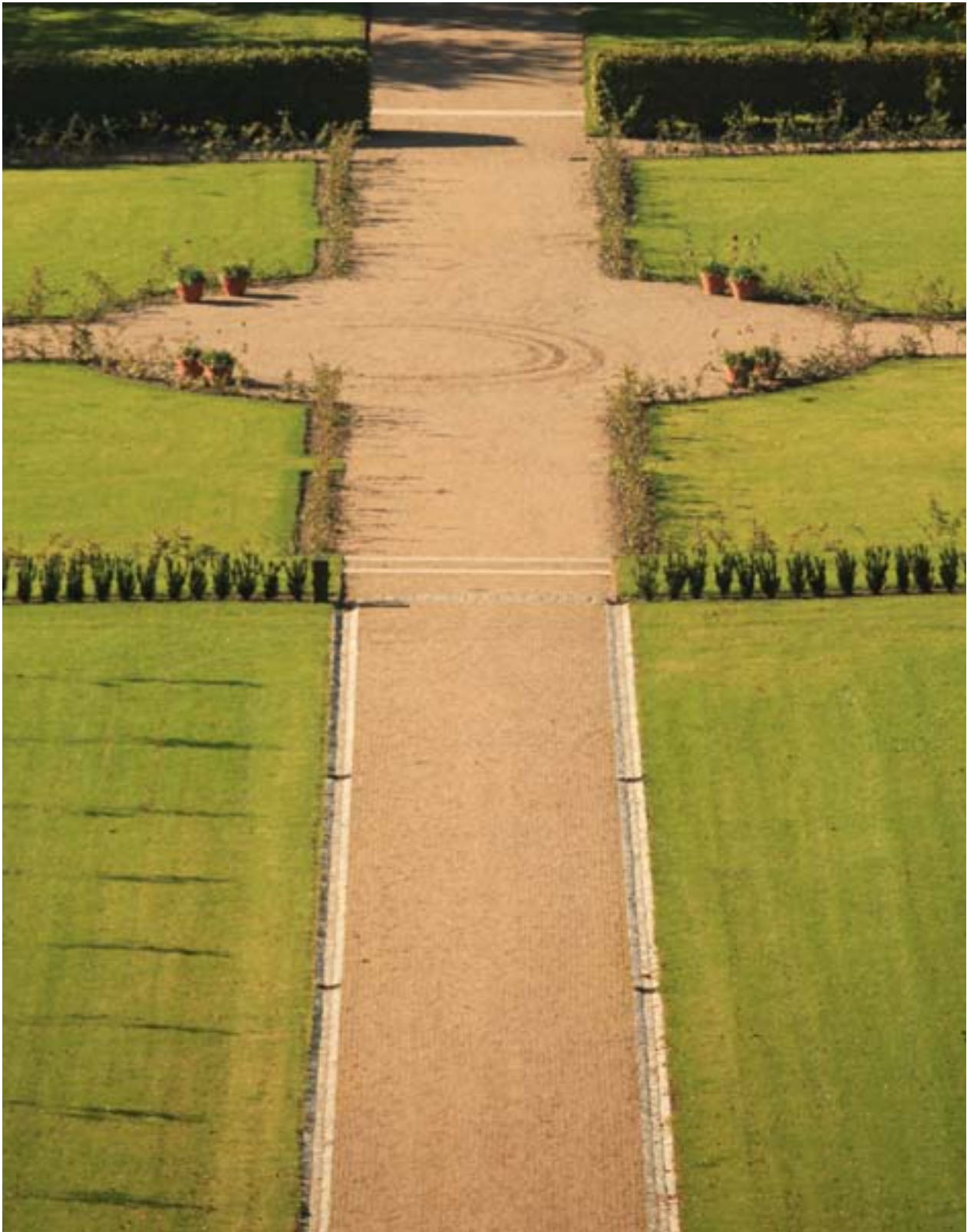
Afvandingsrender og kraftigt sidefald på grusstien hindrer erosioner på stejle stier. Tirsbæk.
