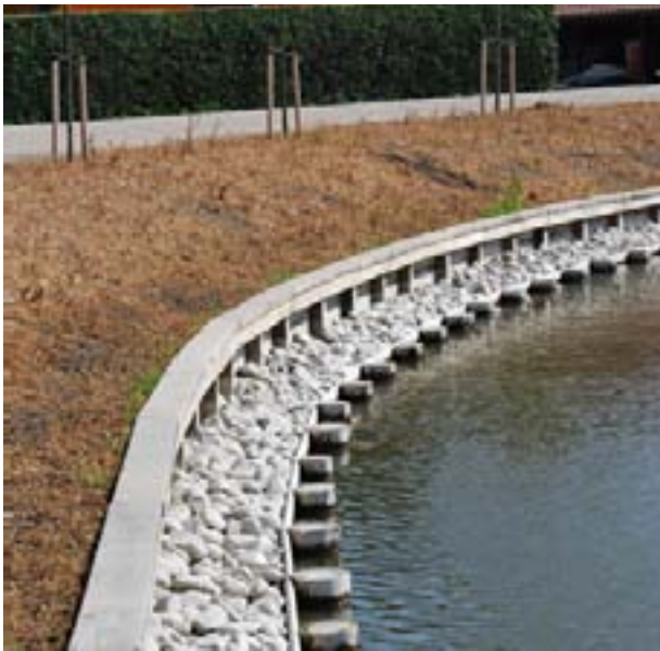
Kant af træ og sten kan klare vandstandsforskelle. Clausholm.
