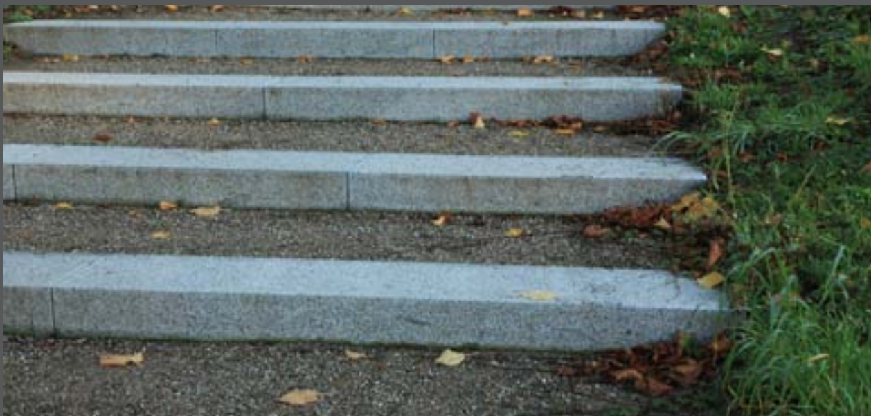
Trappe af granitelementer som trin og slotsgrus til flader. Holstenshuus.
