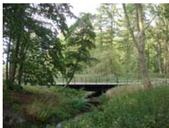
X2. Ny bro på ny vej: Betonbroen kan bæres en 30 ton turistbus, men har ikke forandret åløbet og brinkerne.
