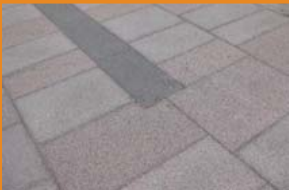
Med granitfliser kan der tegnes mønstre i belægningen. Kanterne bør altid være affaset.
