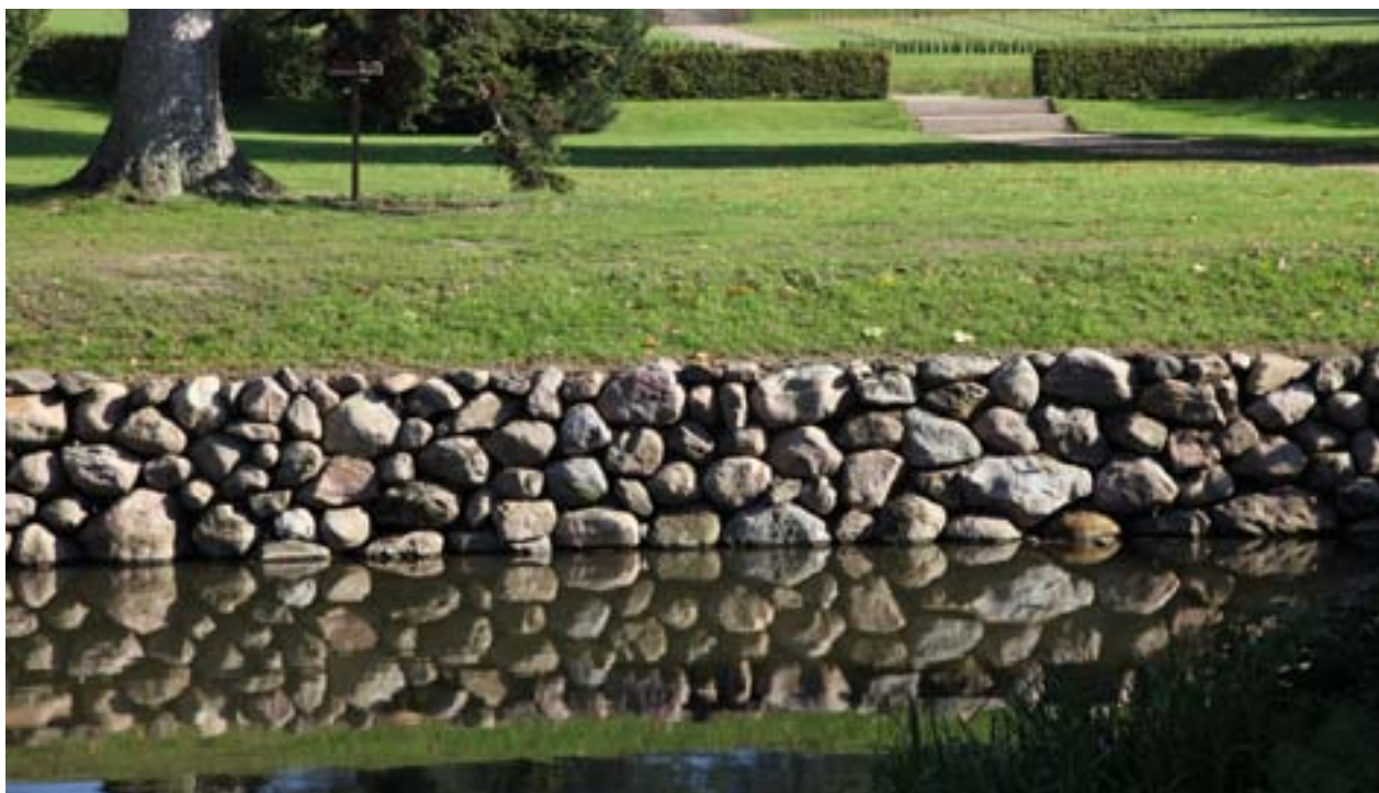
Renoveret kampestensmur danner kant om voldgrav. Tirsbæk.
