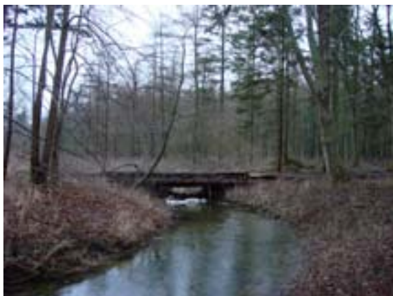
X2. Træbro ved hjulspor: Broen var bygget af hele træstammer med fæste langt fra åbrinken.
