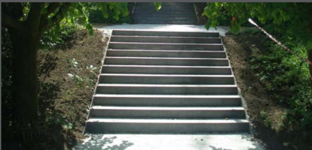
Trappe med forkanter af stål og trædeflade af grus. Engelsholm.
