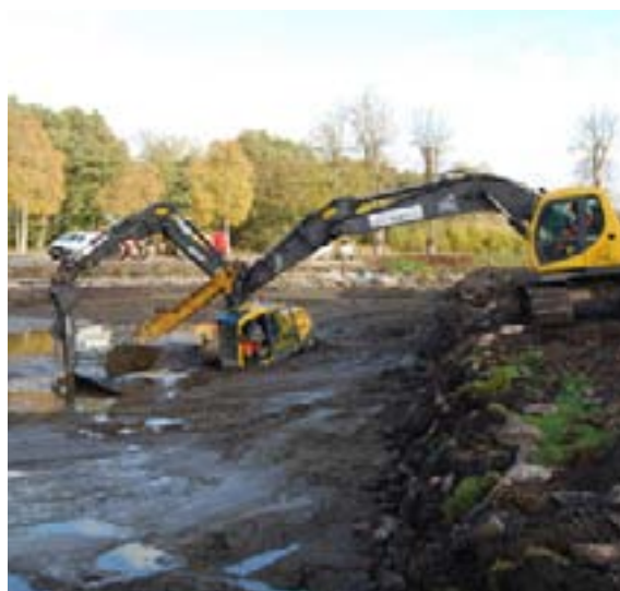
For at få dyndet bragt ud til søbrinkerne og videre væk skal der anvendes flere maskiner. Clausholm.
