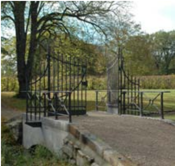
Den gamle bro som indgang til haven for besøgende er renoveret.
