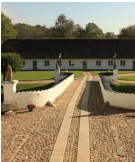
Nyt bordurstensbånd i eksisterende belægning giver bedre tilgængelighed.
