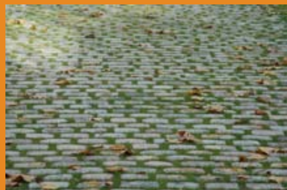
Brosten anvendt som græsarmering med brede fuger.
