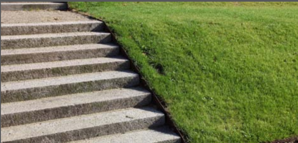
Trappe i granit med stålkanten ind mod græsskrænten giver minimal drift. Tirsbæk.
