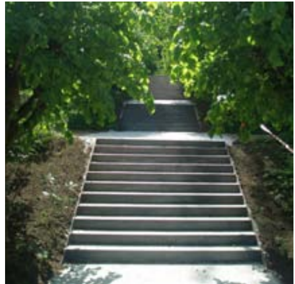
Renoveret trappeanlæg med stålkanter.
