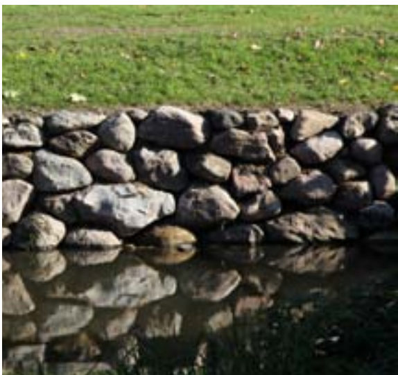
Den rensede og istandsatte bassinkant.
