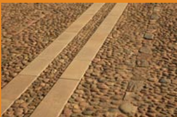
Bordurstensbånd lagt i eksisterende pikstensbelægning. Engelsholm.
