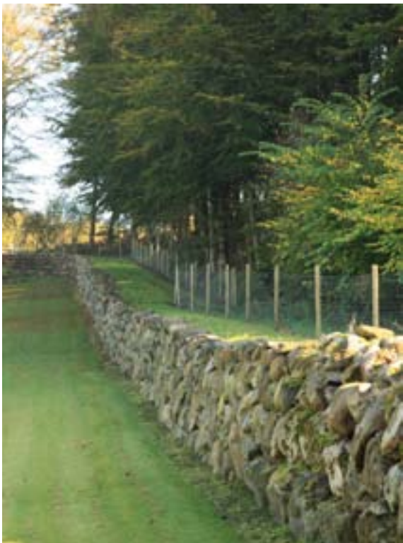
For at sikre den genopbyggede kampestensmur er alle træer ryddet i en zone langs muren. Tirsbæk.
