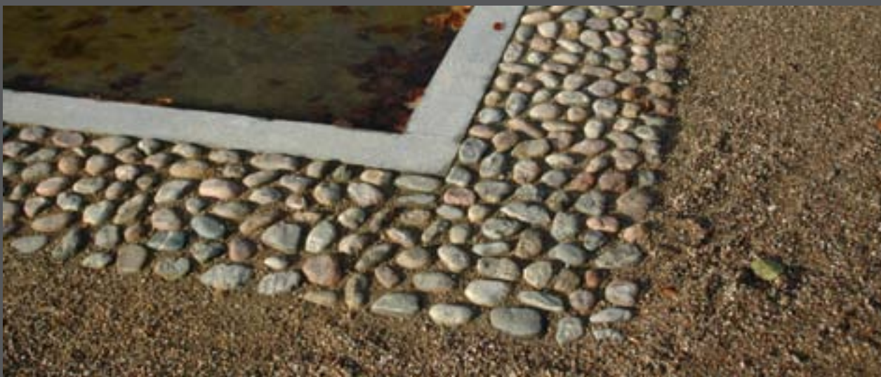
Kant om spejlvandsbassin lavet af beton og markeret af pikstensbelægning. Løvenborg.
