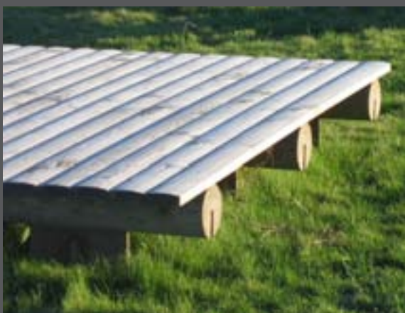
Trædæk udført efter princippet om konstruktiv træbeskyttelse. Træet har ingen jordkontakt og hvor træ møder træ er der ingen vandsamlende lommer. Her kan selv blødt træ som lærk og fyr, holde i en menneskealder
